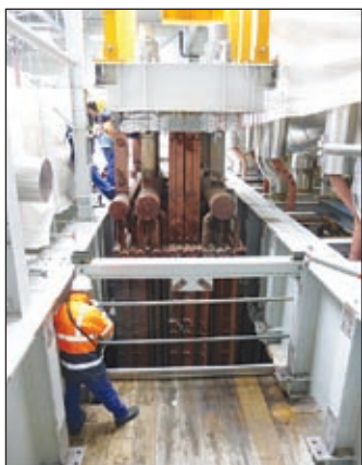
Ausheben des Wärmetauschers
