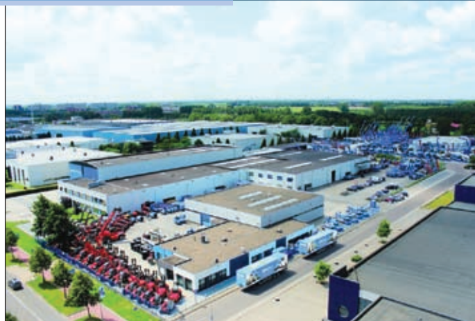
Das neue Areal von Collé in Sittard
