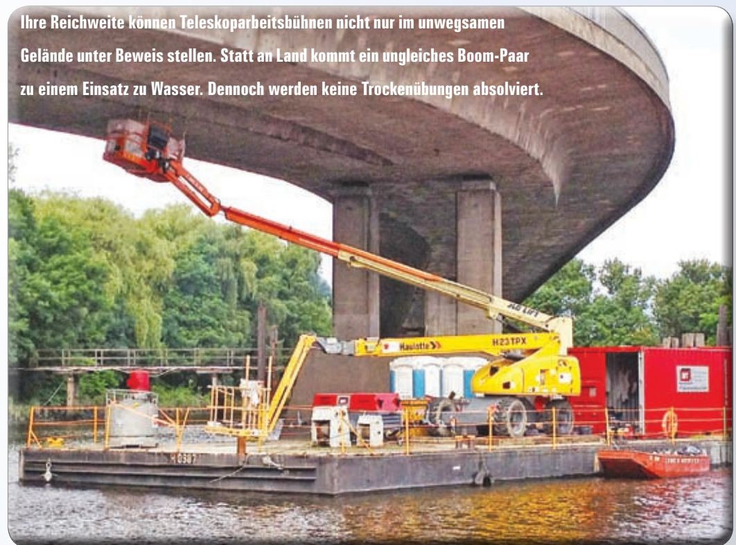
Ungleiches Doppel: Zwei Boomlifts unterschiedlicher Hersteller beim gemeinsamen Einsatz
