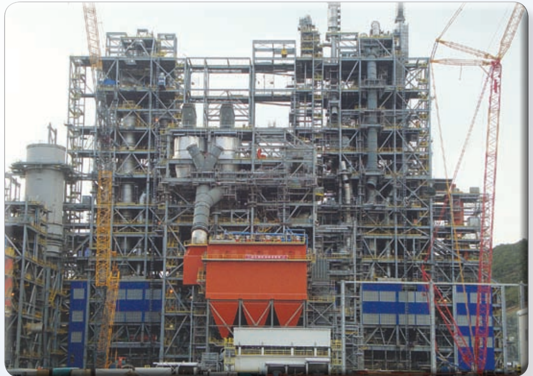
Vier Zahnstangenaufzüge bespielen den Flash Dryer der Koniambo-Nickelmine
