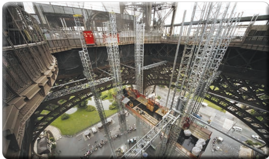
Wie winzige zusätzliche Stützbeine sehen die Mastsektionen am Eiffelturm aus
