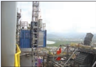
Der Geda PH 2737 Single ist 106 Meter hoch aufgebaut
