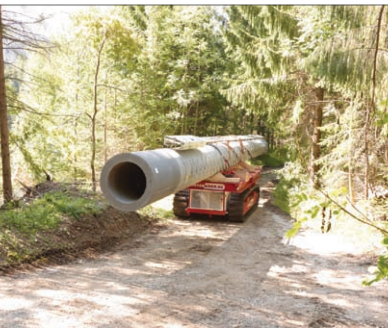
Im Betriebsmodus „Direktladung“ werden die Turmsegmente des Mobilfunkmastes durch das unwegsame Gelände gebracht
