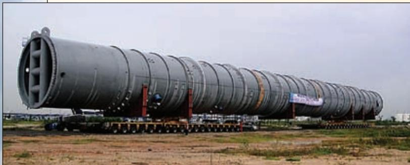
Zum Hilfskran degradiert wurde der große Gittermast-Raupenkran vom Typ Terex CC 8800-1 aus der Flotte von Tiong Woon aus Singapur. Es ging um nichts Geringeres als den Transport und Aufbau der weltweit drittgrößten Xylol-Splitterkolonne. Um den 1.147 Tonnen schweren und 108 Meter hohen Behälter zu transportieren und in seine Endposition zu heben, arbeitete der mit 1.600 Tonnen Tragfähigkeit ausgestattete Raupenkran mit einem von Tiong
