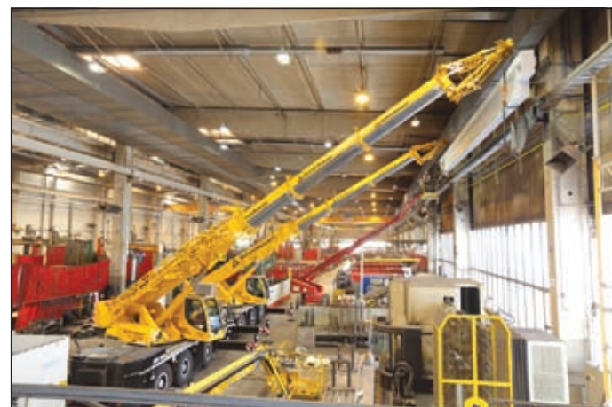
Beim Austausch der Kranbahn eines Brückenkrans setzte Schmidbauer gleich zwei 45-Tonner des Typs LTC 1045-3.1 ein
