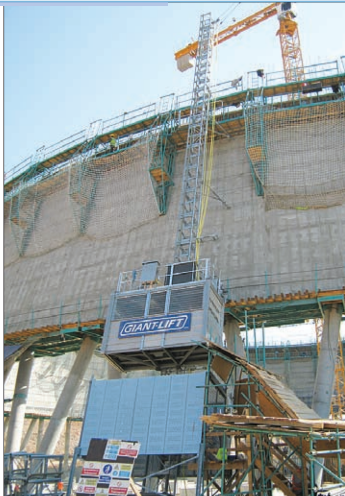
20 Tonnen schwerer Giant-Lift beim Kühlturmbau im türkischen Silopi
