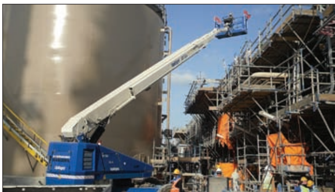
Gleich 20 Maschinen von Snorkel setzt das Bauunternehmen NSH auf der Großbaustelle des Barzan Gas Projektes in Katar ein. Neben T85J werden auch die großen T126J genutzt.
