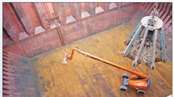
Die erste Bühne setzt sicher im Laderaum des liberischen Frachters auf
