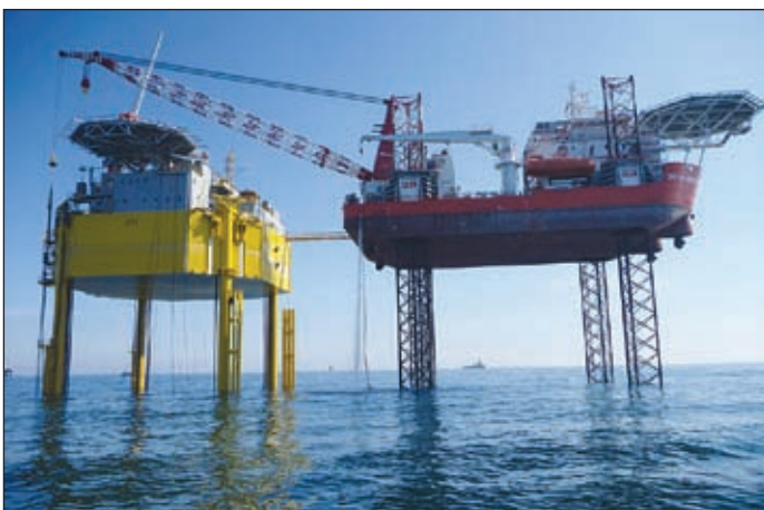
Das oberste Deck der erfolgreich installierten Umspannstation liegt 90 Meter über dem Meeresgrund
