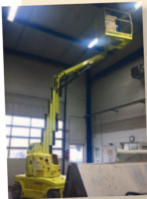
Bild links oben: Reinigungsarbeiten im Bereich der Decke mit einem Staubsauger
