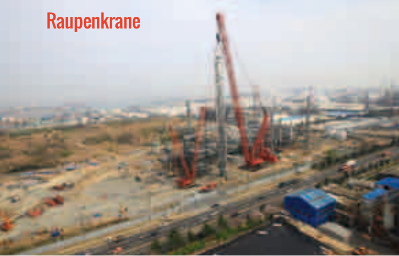
Manitowocs 31000 hebt 670 Tonnen in einer Raffinerie
