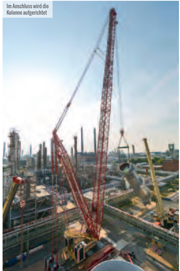
Im Tandem heben die Terex-Raupe SL3800 und Liebherrs 500-Tonner LTM 1500 das Teil
