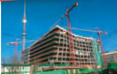
In Moskau wird am neuen futuristischen Gebäude des russischen Senders NTV auf zwei Potain-Obendreher gesetzt
