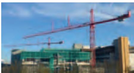
Bei laufendem Betrieb des Ingolstädter Krankenhauses arbeiten ein Wolff 9025.20 und ein Wolff 8540.20 auf der Baustelle
