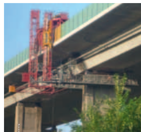
An der Talbrücke Uttrichshausen auf der A7 war Wemo-Tec mit den zwei Spezialgeräten MBS 230 und MBS 170 zugange
