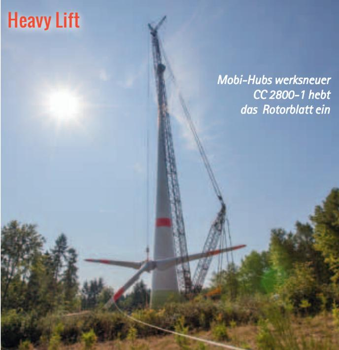
*Mobi-Hubs werksneuer CC 2800-1 hebt das Rotorblatt ein*
