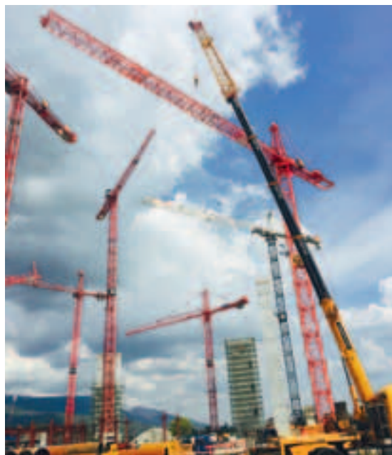
Auf der Großbaustelle Biogen in Luterbach (Schweiz) entsteht mit Kaufmann-Kranen die modernste Medikamentenherstellungsanlage weltweit
