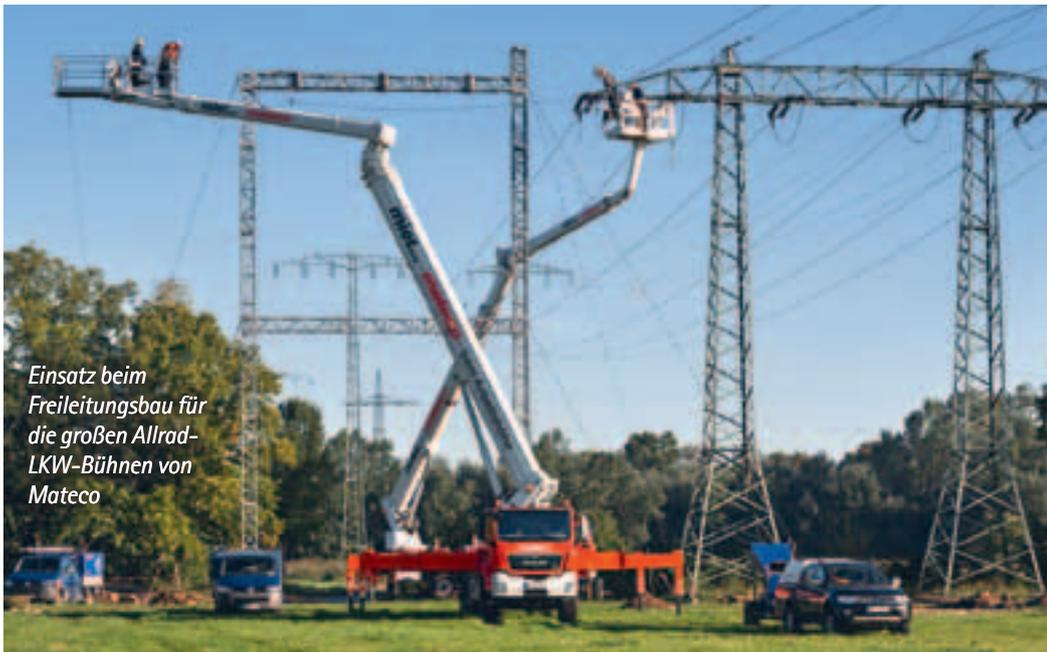
Einsatz beim Freileitungsbau für die großen Allrad-LKW-Bühnen von Mateco
