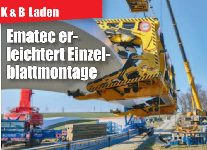
Die Ematec AG hat ihre Rotorblatttraversen RBT und RBT Bunny für die Einzelblattmontage um zahlreiche innovativen Features bereichert: 180-Grad-Blattanschlag, Adaptierung an unterschiedliche Blattgrößen und eine erhöhte Traglast von bis zu 16 Tonnen. Außerdem neu sind ein Ferndiagnosesystem via Internet, ein Kettengehänge mit Ausgleichswippe, feuchtigkeitsabweisende Druckkissen, ein teleskopierbarer Anschlagpunkt für die persönliche
