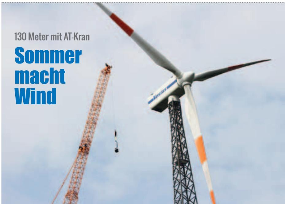
Im Windpark Borstel in Achim bei Bremen musste der Hilfsgenerator einer Vestas V66-Windkraftanlage ausgebaut und durch einen neuen ersetzt werden – in einer Höhe von 130 Metern. „Diese Höhe erreichen eigentlich nur Raupenkrane, die bei der Aufstellung der Anlagen eingesetzt werden. Für den Tausch eines Generators mit einem Gewicht von gerade einmal einer Tonne wäre ein solcher
