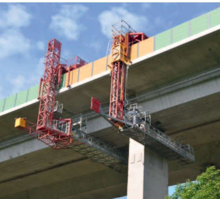
Ein Sanierungsgerät des Typs MBS 230 nutzt Wemo-tec für Arbeiten an der Lützelbachtalbrücke. Der Aufbau eines Sanierungsgerätes benötigt zwar mehr Zeit, das Gerät spart aber reichlich Platz
