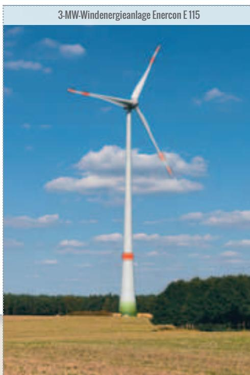
3-MW-Windenergieanlage Enercon E 115
