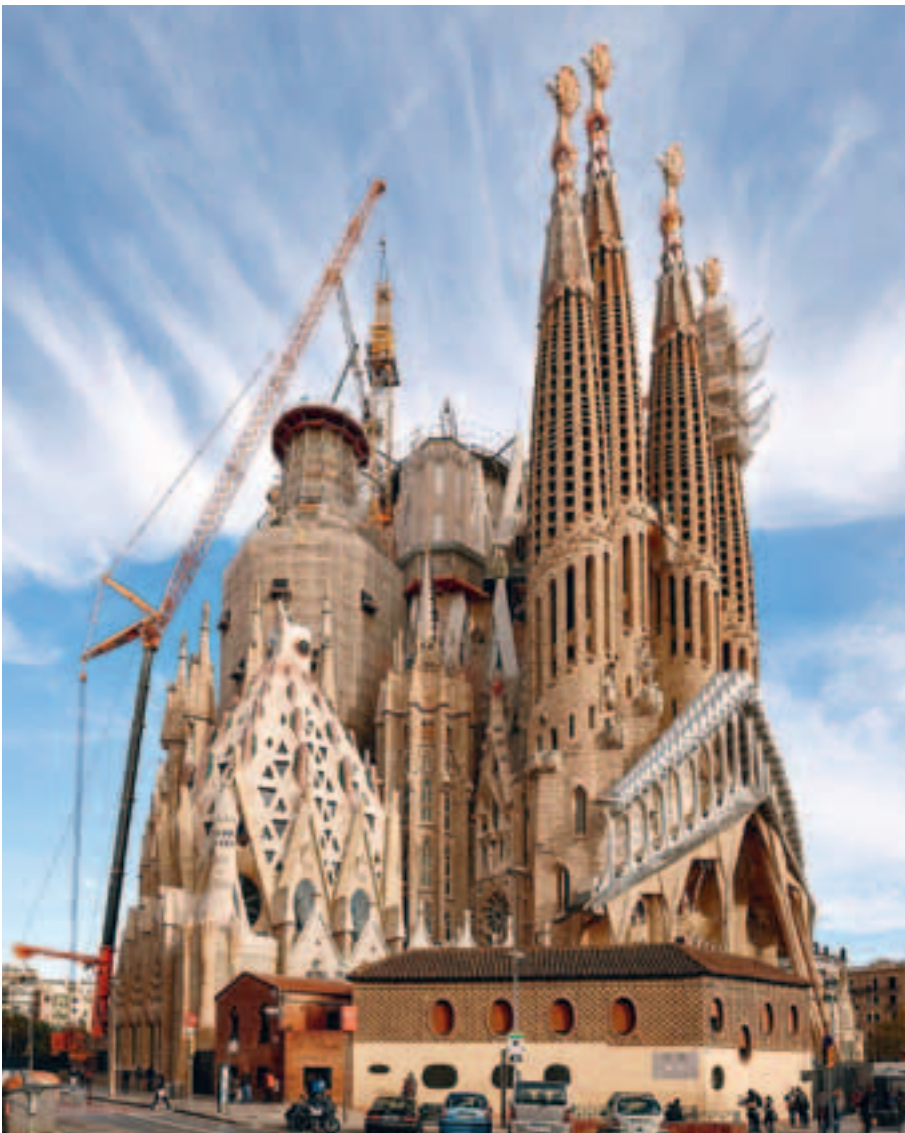
» Traum- und Knochenjob zugleich: Grúas Rigar aus Spanien hat bei einem schwierigen Kraneinsatz an der weltberühmten Sagrada Família in Barcelona alle Register gezogen. Um einen der drei großen Turmdrehkrane zu versetzen, rüstete Rigar seinen 500-Tonnen-Mobilkran LTM 1500-8.1 mit 165 Tonnen Ballast und einer 70-Meter-Wippspitze.
