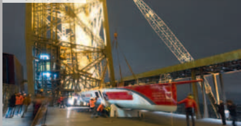
Angelandet: In rund 60 Meter Höhe wird das Boot auf vormontierten Halterungen punktgenau abgesetzt
