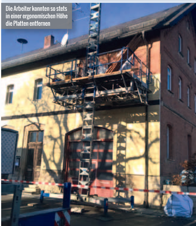
Die Asbestsanierung wurde gegenüber einem Gerüst sicherer und schneller mit einer Mastkletterbühne von Fraco ausgeführt
