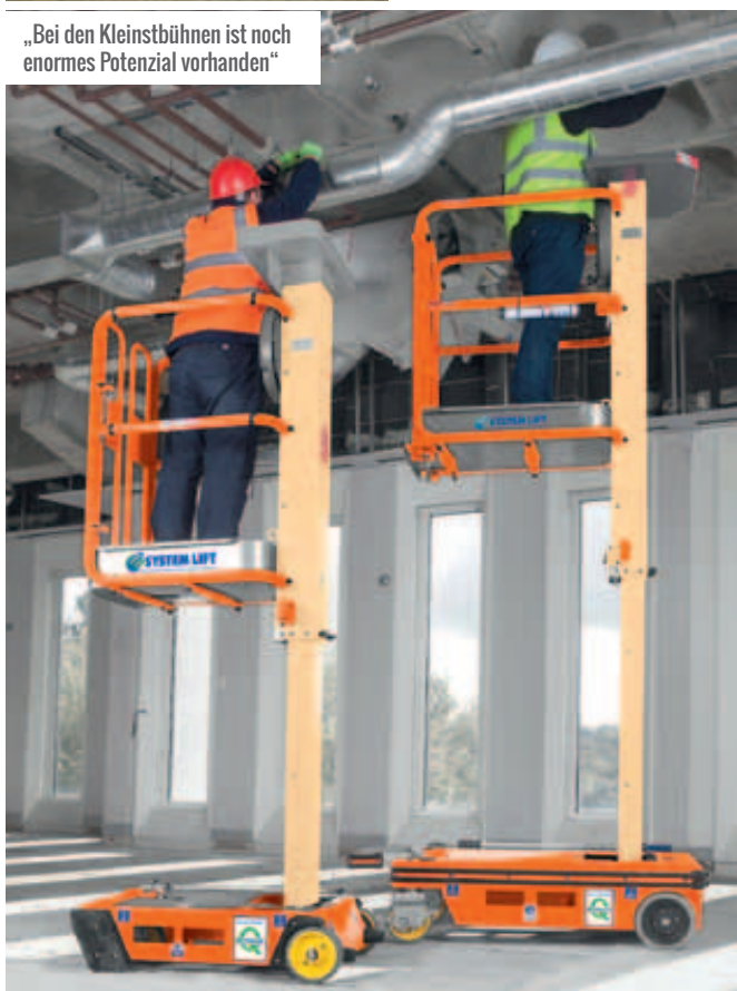
Unterwegs auf allen Baustellen
