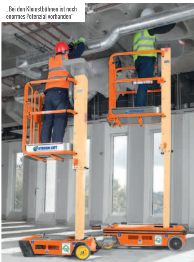
Unterwegs auf allen Baustellen
