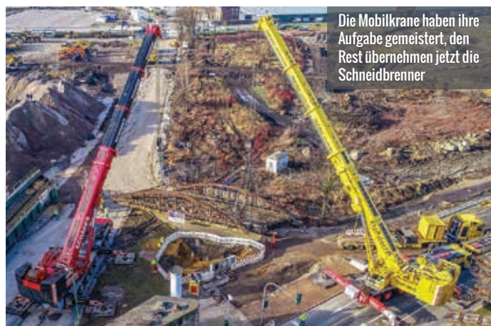
Feinfühlig manövrieren die Kranfahrer die große Stahlkonstruktion zwischen beiden Auslegern hindurch
