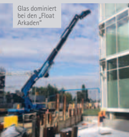
Die Kleinkrane nehmen die Scheiben vom Bock auf und heben sie teilweise direkt ein
