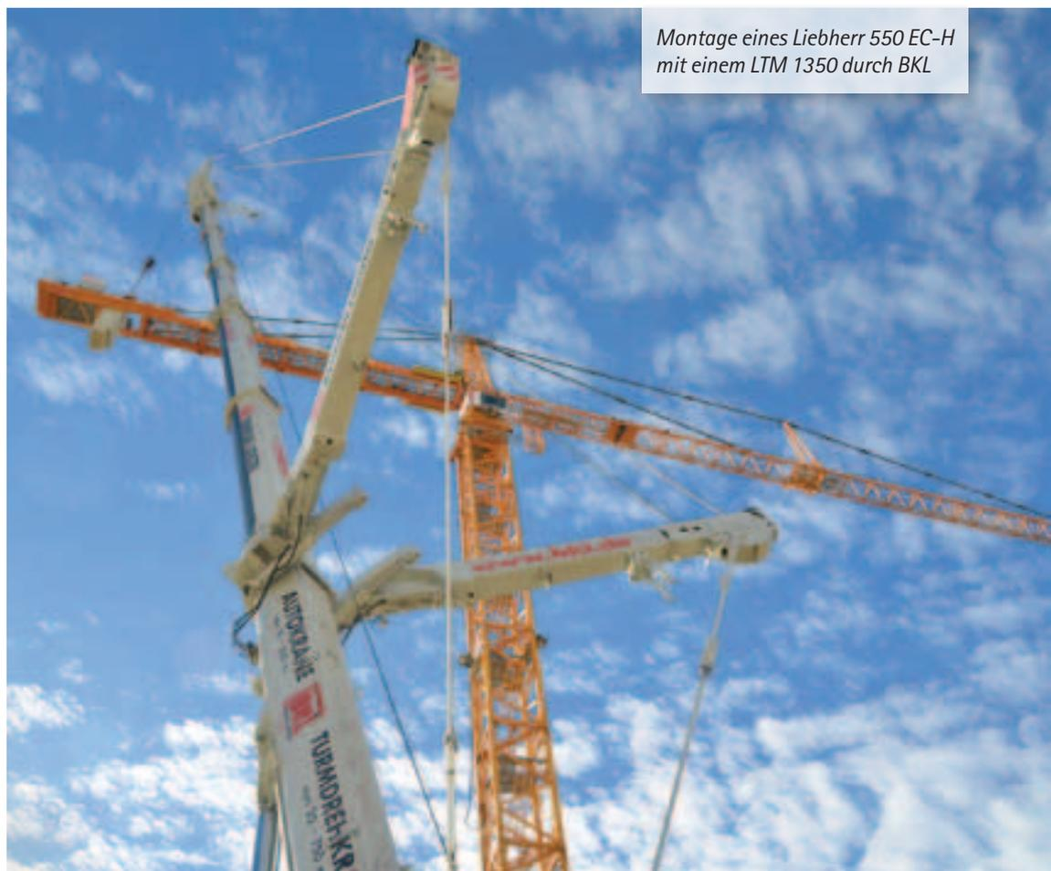
Montage eines Liebherr 550 EC-H mit einem LTM 1350 durch BKL
