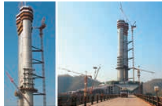
Zu Ehren des indischen Staatsmannes Sardar Patel wird auf einer Flussinsel im Bundesstaat Gujarat die Statue der Einheit errichtet, mit 182 Metern die höchste Statue der Welt. Nach fünfjähriger Bauzeit – mit drei Potain-Wippern MR 295 H20 und einem MC 205 B Laufkatzauslegerkran, ausgestattet mit Zoning- und Antikollisionssystemen von AMCS – ist die offizielle Einweihung für den 31. Oktober geplant
