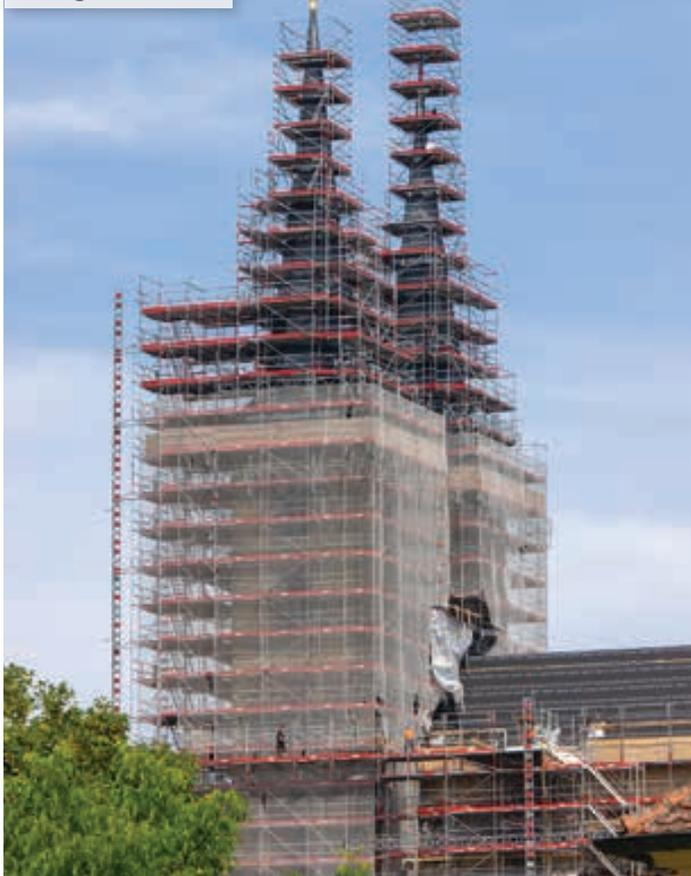
Innengerüst, ein 16.000 Kubikmeter großes Raum- und ein 1.500-Quadratmeter-Flächengerüst zum Einsatz. Neben unzähligen Handwerkern aus sämtlichen Bereichen unterstützen neun Transportbühnen von Geda die Arbeiten.
