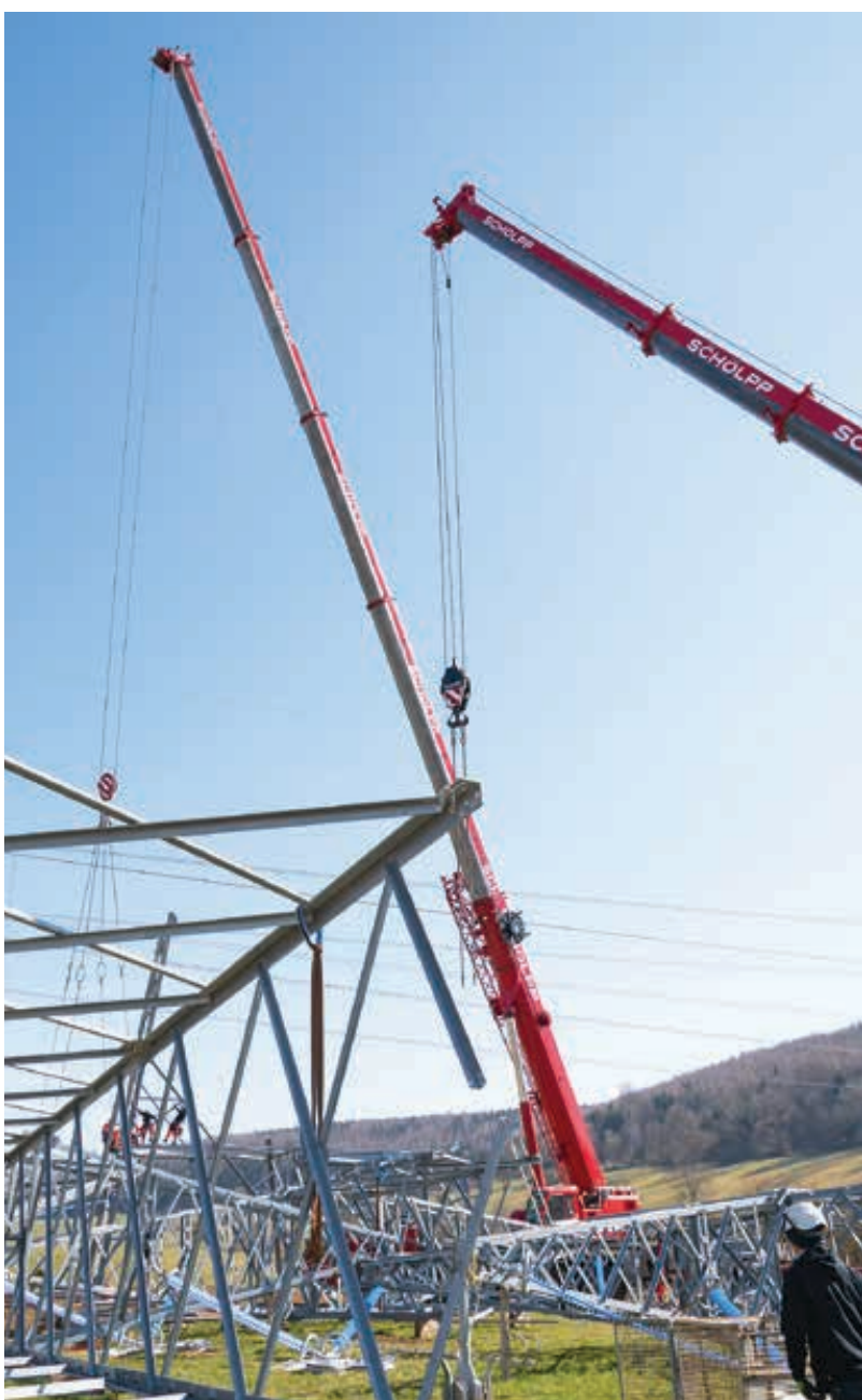
Scholpp rüstet mit seinen 220- und 70-Tonnern seit 2018 die 90 Jahre alte Stromtrasse von Reutlingen-Rommelsbach nach Herberlingen auf. Bei diesem Großprojekt werden insgesamt 11.000 Tonnen Stahl, 1.000 Tonnen Fundamentbeton und über 1.500 Kilometer Aluminium-Leiterseil verbaut
