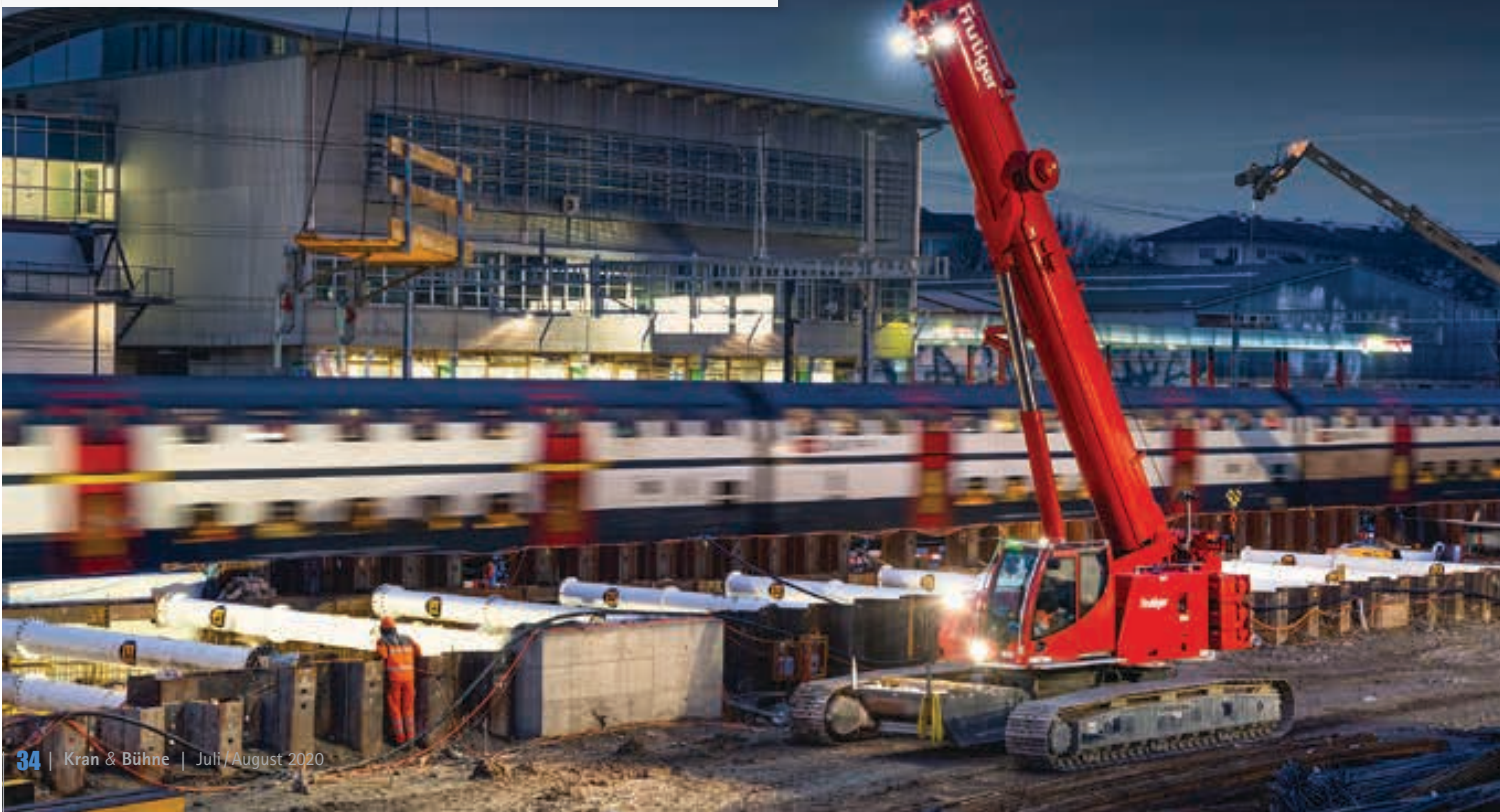
Auf der rund 1.200 Meter langen Baustelle „Wylerfeld“ im Nordosten der Stadt Bern entsteht in offener Bauweise unter anderem ein neuer Tunnel. Stammgast dabei: der LTR 1060 der Frutiger AG
