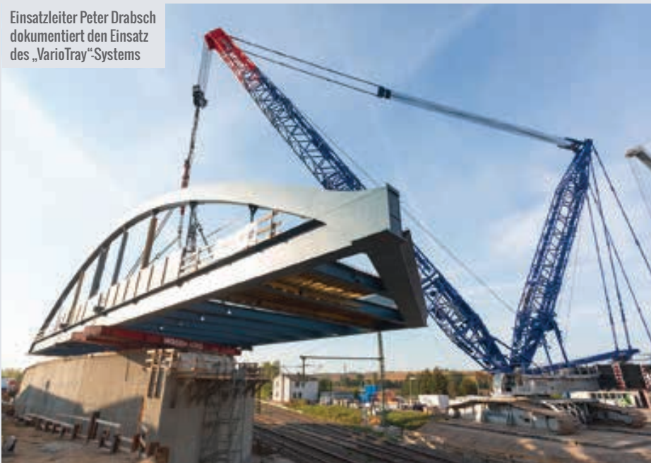
Mit vereinten Kräften: Das Teil eines Fachwerkträgers wird vom LTM 11200 und vom LTM 1750 positioniert
