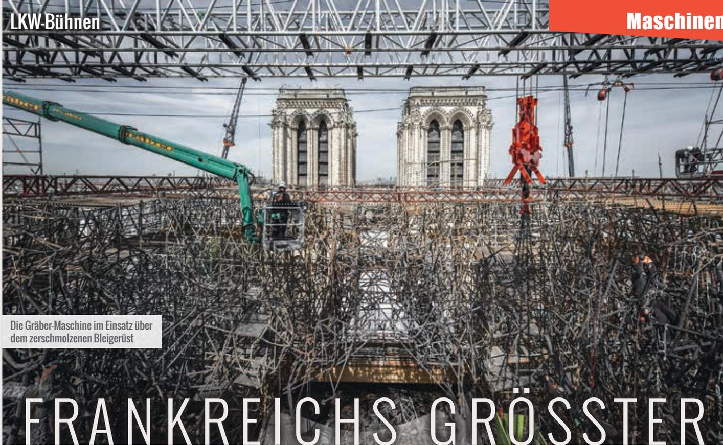
Die Gräber-Maschine im Einsatz über dem zerschmolzenen Bleigerüst
