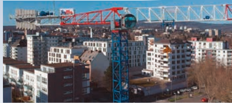
Kwitek Krane und Eurogru haben zwei Raimondi MRT 234-12 auf einer Baustelle in Wiesbaden im Einsatz
