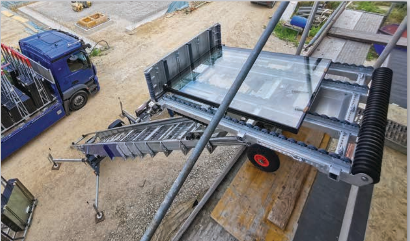
Bauaufzug für Sicherheitsfenster
