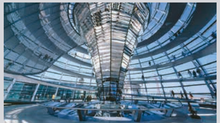
Mittels eines Trichters wird nicht nur Licht, sondern auch Frischluft in die Parlamentsräume geleitet (Bild: DBT)
