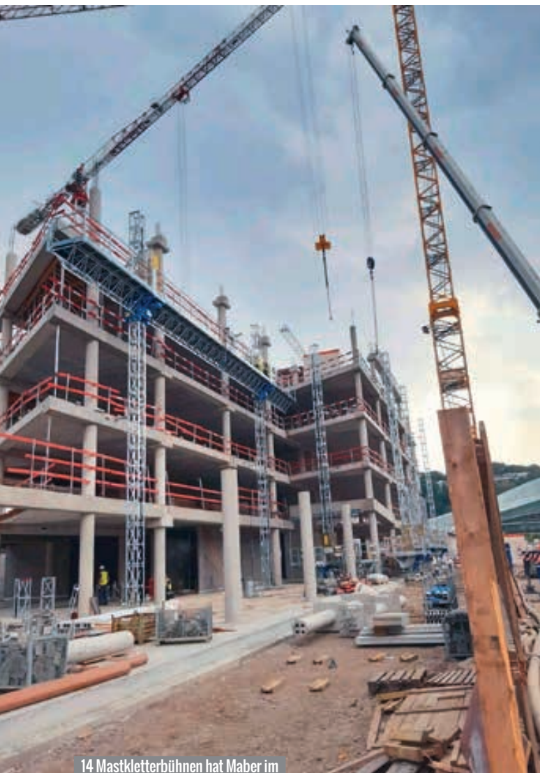
14 Mastkletterbühnen hat Maber im belgischen Lüttich im Einsatz
