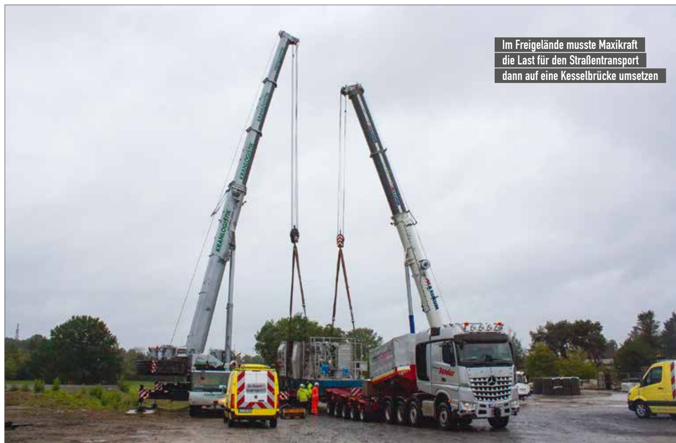
Platz gab es kaum, aber es reichte für Maxikraft, um den Kessel herauszuheben und auf den Transporter zu stellen
