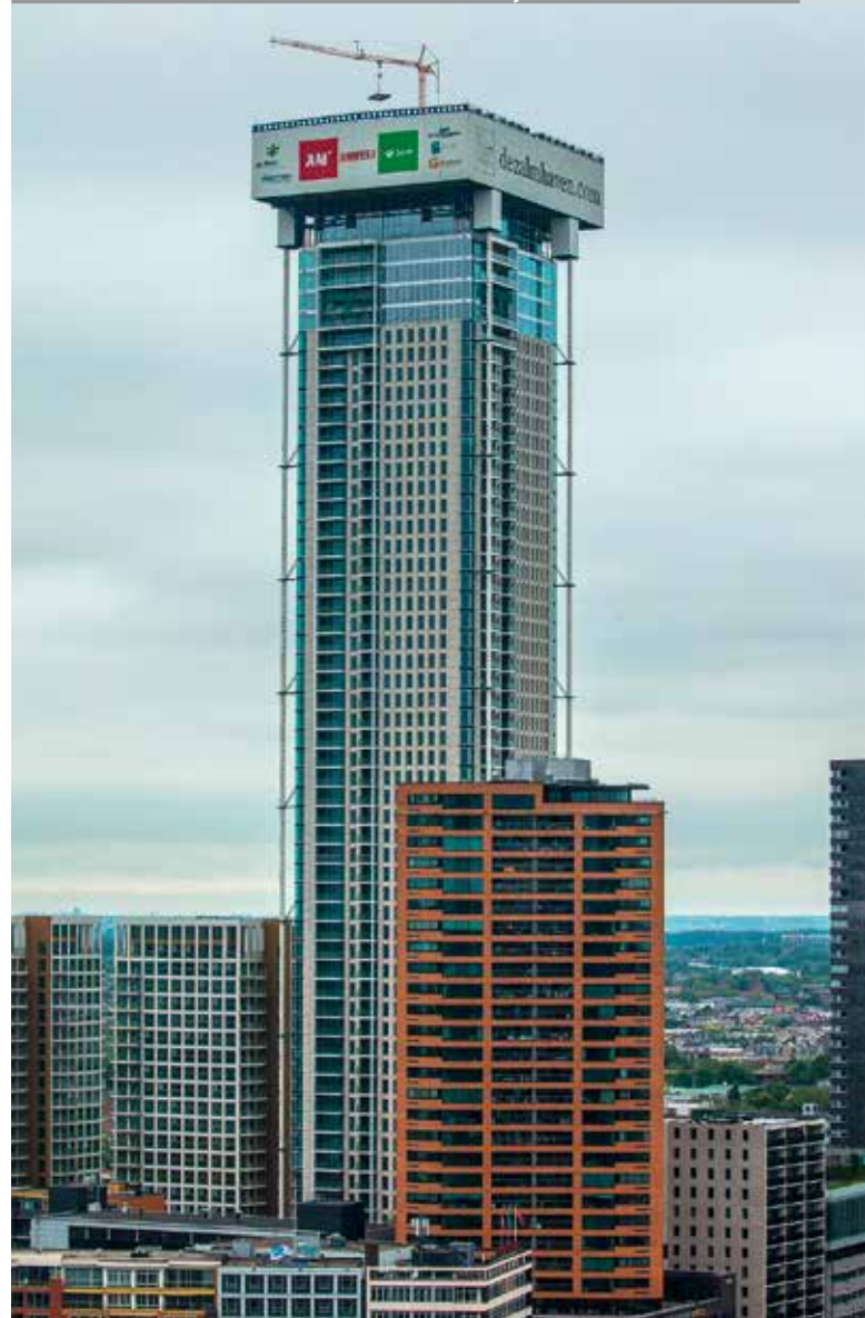
Liebherr-Schnelleinsatzkran 34 K obenauf beim Projekt Zalmhaven in Rotterdam
