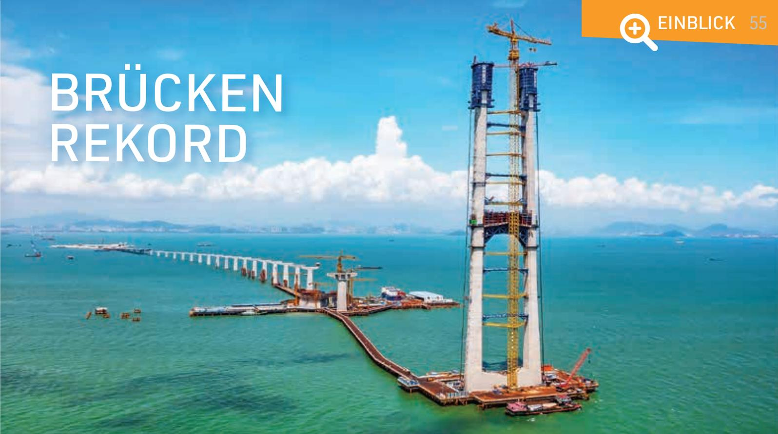
→ Potains riesiger Turmdrehkran MD 3600 ist beteiligt an einem neuen chinesischen Brückenrekord. Nach ihrer Eröffnung wird die Lingdingyang-Brücke die höchste und größte Überwasser-Stahlkastenträger-Hängebrücke der Welt sein. Sie wird eine Spannweite von stolzen 1.666 Metern aufweisen. Zwei 270 Meter hohe Schrägseiltürme – auch dies ein neuer Rekord – fungieren als Stützpfiler.
