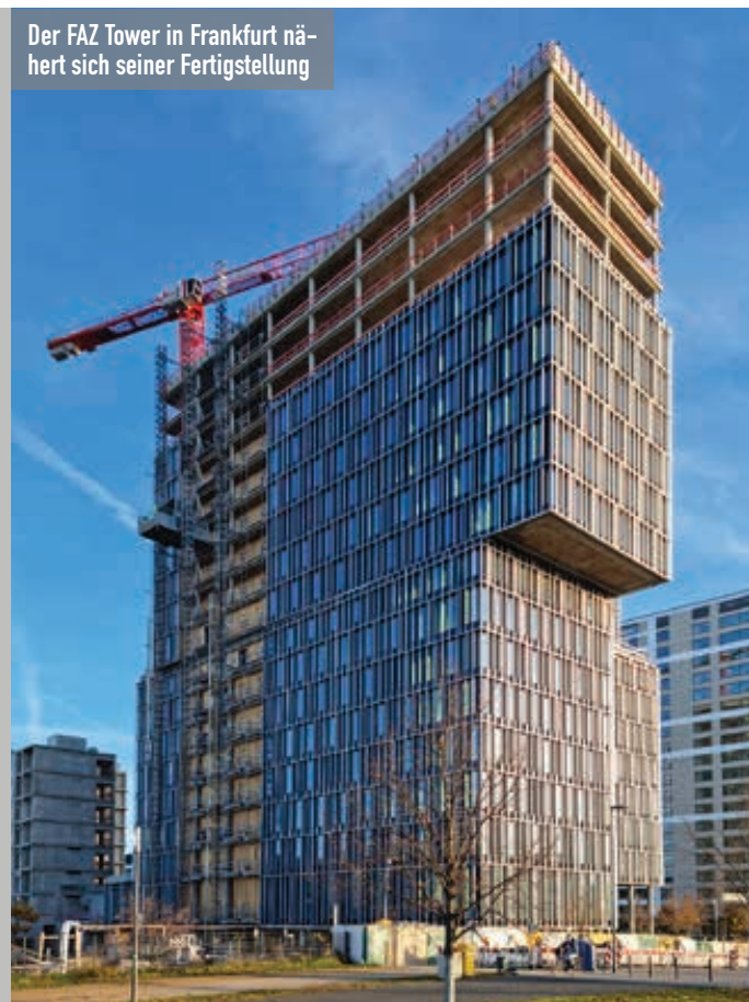
Freistehend bis zwölf Meter Förderhöhe: Geda 1500 Z/ZP F
