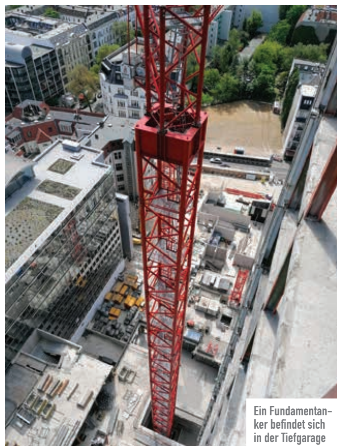
Eng geht es her auf der Berliner Baustelle
