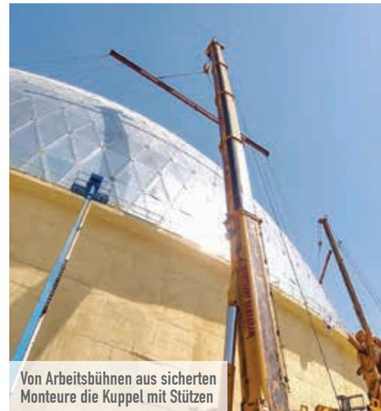
Von Arbeitsbühnen aus sicherten Monteure die Kuppel mit Stützen
