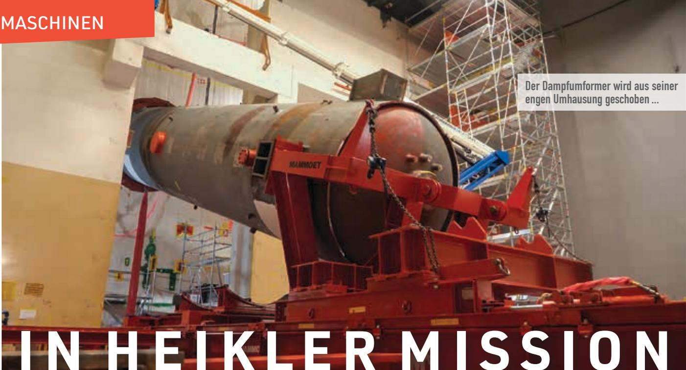
Der Dampfumformer wird aus seiner engen Umhausung geschoben ...
