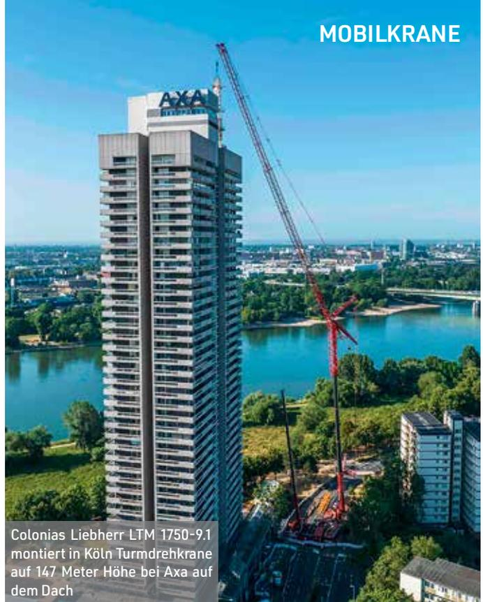
Colonias Liebherr LTM 1750-9.1 montiert in Köln Turmdrehkrane auf 147 Meter Höhe bei Axa auf dem Dach
