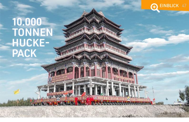
→ Mithilfe von insgesamt 300 SPMT-Achslinien hat China Shipping Vastwin Project Logistics einen Komplex aus fünf Gebäuden um 600 Meter versetzt. Das schwerste Teil darunter wog über 10.000 Tonnen. Für den Transport des 43 Meter hohen und 36,9 Meter langen und 31,5 Meter breiten Hauptgebäudes waren 300 SPMT-Achslinien und zehn PPUs von Scheuerle nötig. Insgesamt brachte es der schwerste Einzeltransport
