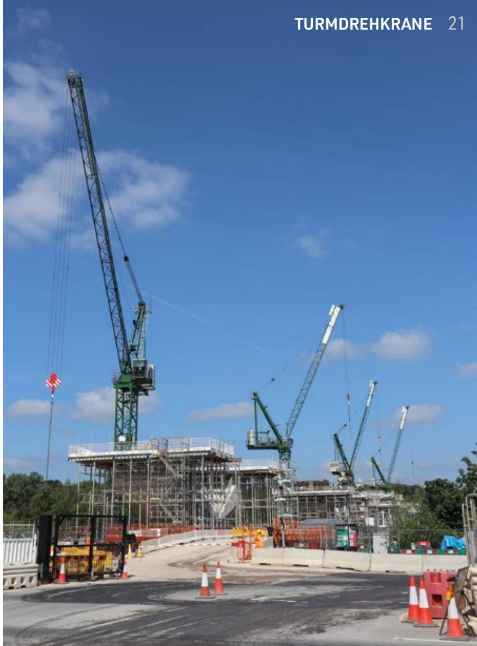
Insgesamt elf Potain MR 225 A errichten das Colne Valley Viadukt im Nordwesten Londons
