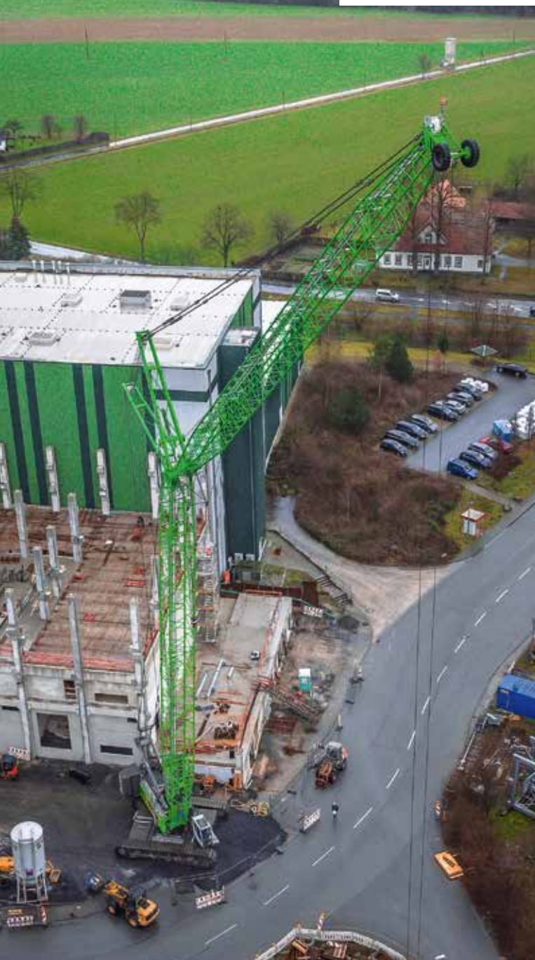
Der Sennebogen 5500 G beim Hausbau in Ibbenbüren
