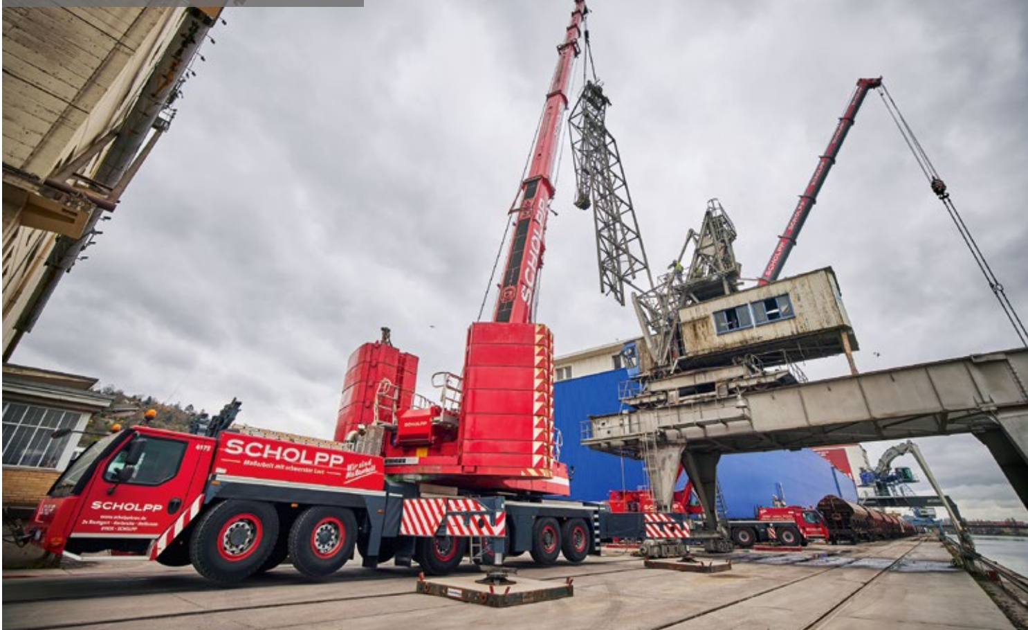
Scholpp zerlegt in Stuttgart einen 170 Tonnen schweren Hafemobilkran mit Liebherr LTM 1350-6.1 und 1230-5.1
