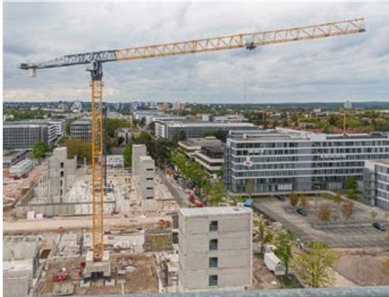
BKL montiert drei Krane am Siemens Campus in München, zwei Sáez TLS 80 20T und einen Comansa 21 LC 750
